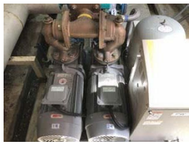
⑨：旧滝野庁舎側の加圧給水ポンプ
