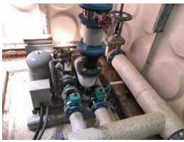
⑩：旧滝野庁舎側の加圧給水ポンプ
