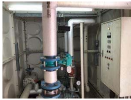
⑨：旧滝野庁舎側の加圧給水ポンプ
