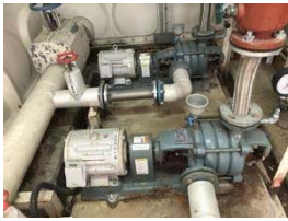
⑩：旧滝野庁舎側の加圧給水ポンプ
