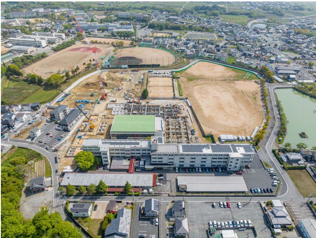
全景 北側上空から撮影（令和5年4月末撮影）
