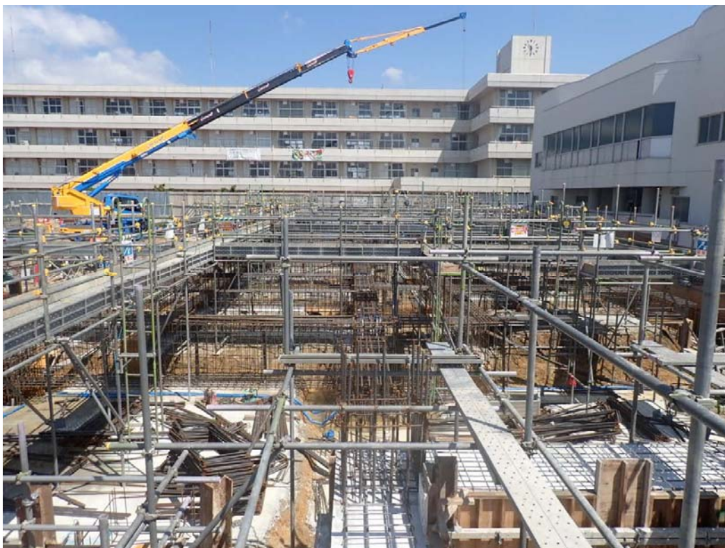
交流棟 地中梁コンクリート養生中（令和5年4月末撮影）
