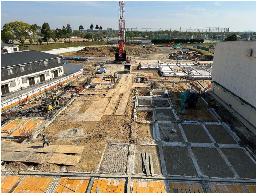
体育館棟 地中梁コンクリート打設完了（令和5年4月末撮影）
