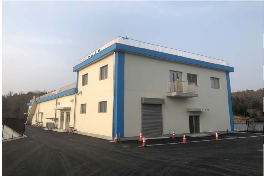
広沢浄水場・新浄水設備棟
