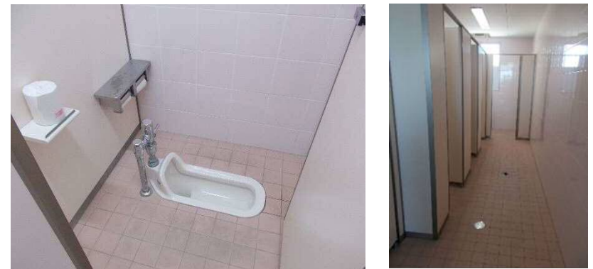
現在の社中学校トイレ
