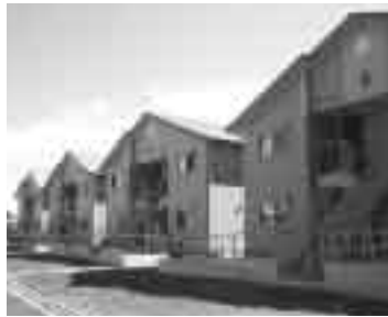
改築した市営高岡岡地
