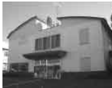
加東ケーブルビジョン局舎
