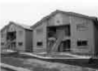
高岡市営住宅
