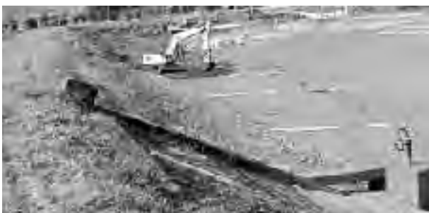
傳之丞池整備工事
