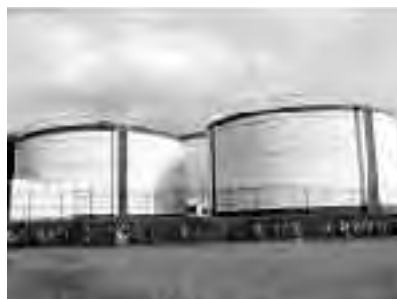
高区配水池（松沢地区）
