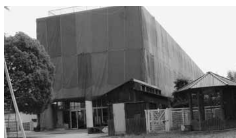
外壁落下保護シートが設置された米田小学校
