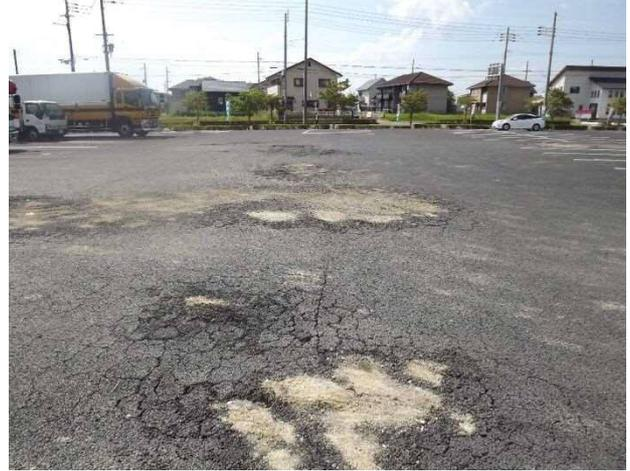
補修に際し、路盤まで損傷している原因を十分調査したうえで修繕方法の検討を行い適切な施工をしなければ、すぐ同じ状況になることが予測されること、加えて、夏場は路面の温度が上がりアスファルトが変形しやすくなり、変形により同様の状況が他の箇所でも生じる恐れがあることなどから、現在は現状の確認にとどめています。
