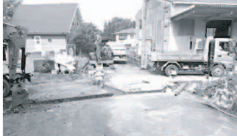
嬉野東地区工事状況
