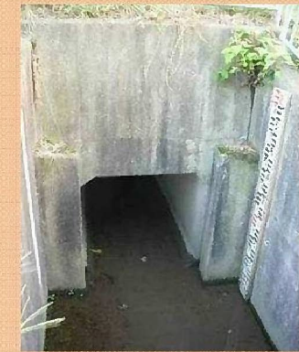
【写真】万願寺川 古宮下樋門(小野市西脇町)
