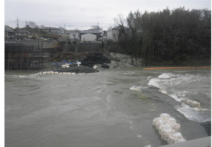
被災状況写真（右岸 上滝野側から撮影）
