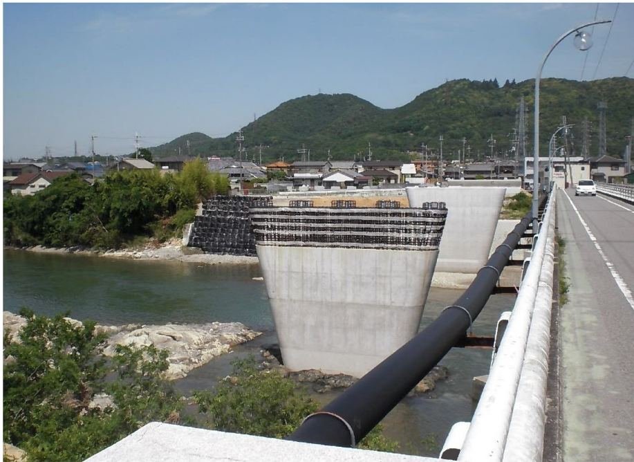
左岸 新町側から撮影
