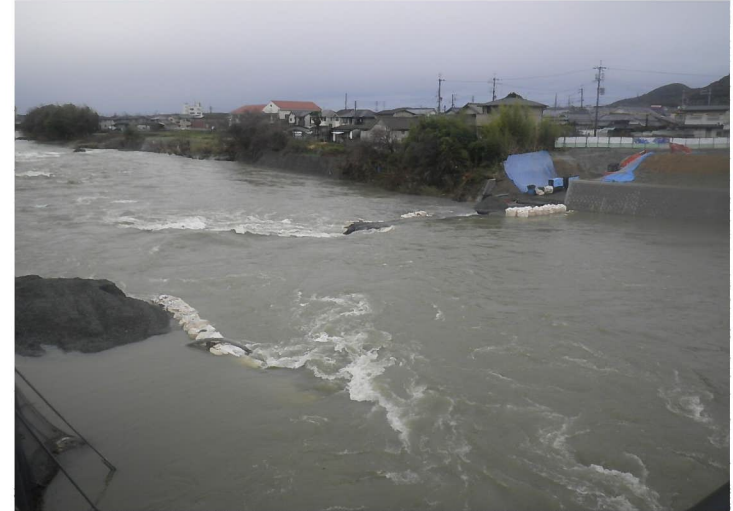
被災状況写真（滝見橋から撮影）
