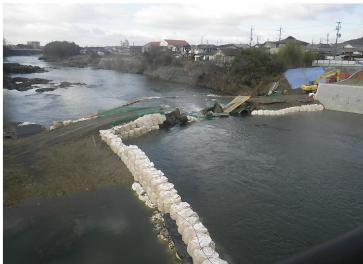
被災状況写真（滝見橋から撮影）
