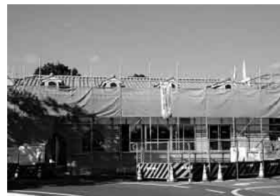
建設中の病児病後児保育施設
