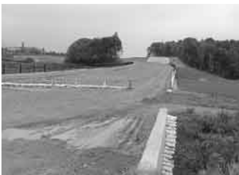
工事中の社バイパス（山国工区）
