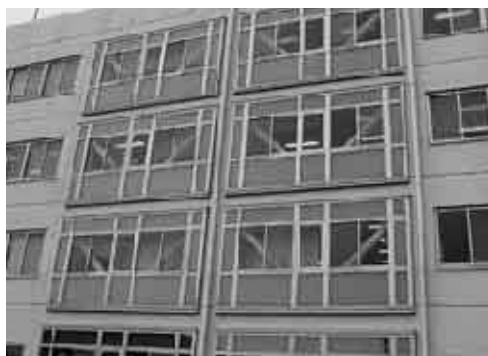
耐震補強されている北播磨県民局
