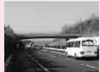
中国縦貫自動車道にかかる小山橋
