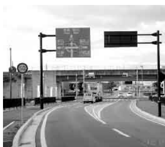
全線開通した国道372号（田中地内）
