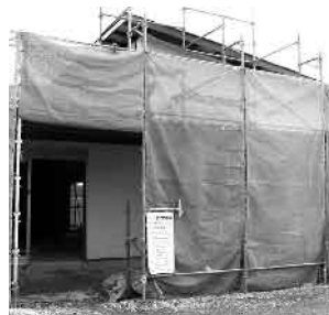
東条東アフタースクール 工事現場
