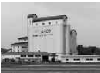
JAみのり カントリーエレベーター
