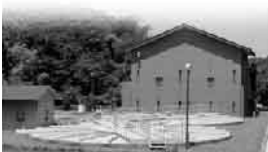
せせらぎ東条の屋外処理施設
