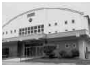
今年度耐震診断が実施される杜小中学校体育館
