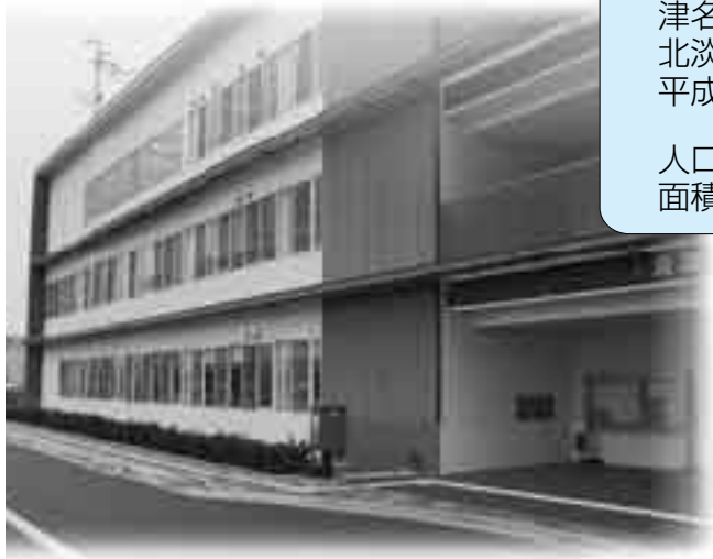
淡路市庁舎（所在地…淡路市生穂新島）
