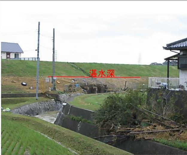
安取樋門付近
