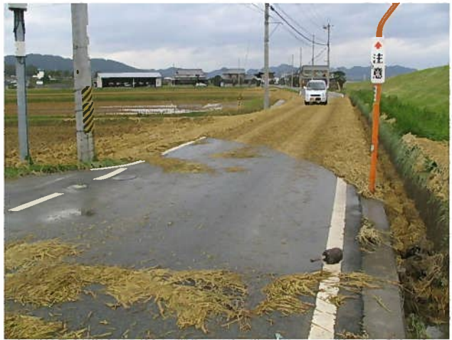
道路冠水痕跡
