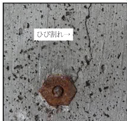
(1) コンクリート壁ひび割れ 鉄筋腐食補修工事の追加
