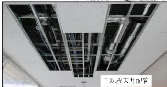
(3) 既存給排水管改修工事の追加
