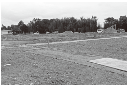
加東みらいこども園西隣に整備中の防災広場(9月利用開始予定)
