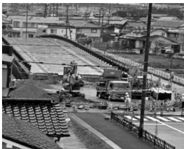
滝見橋架替工事の様子
