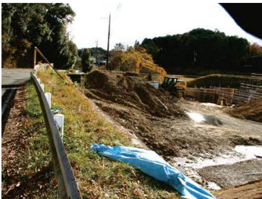
川池の改修工事箇所
