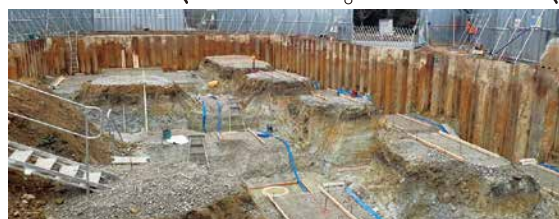
建設中の社地域小中一貫校
