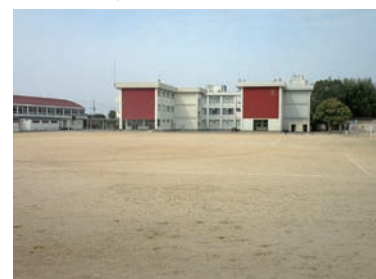
兵庫県に貸す社小学校校舎とグラウンド
