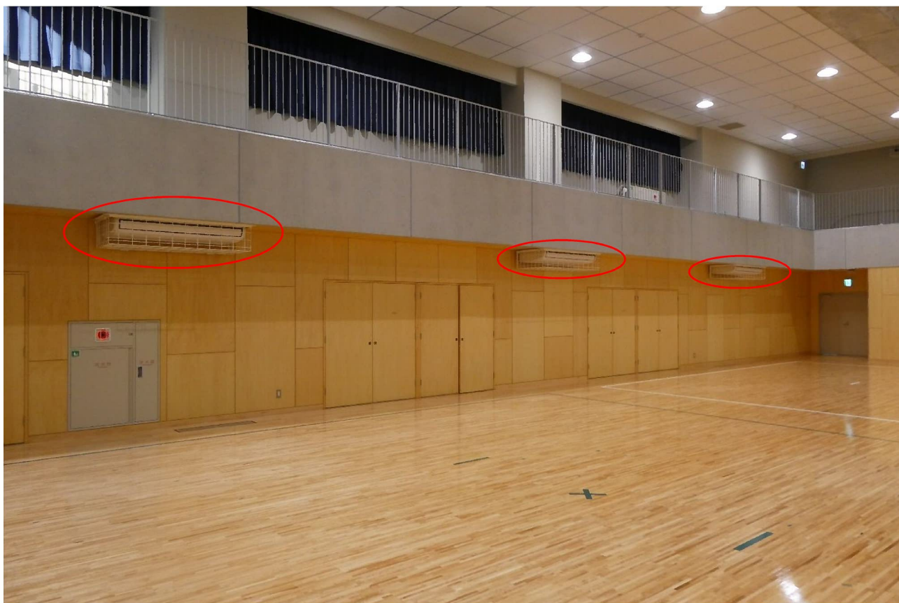
【完成】 武道場エアコン (令和6年12月26日撮影)
