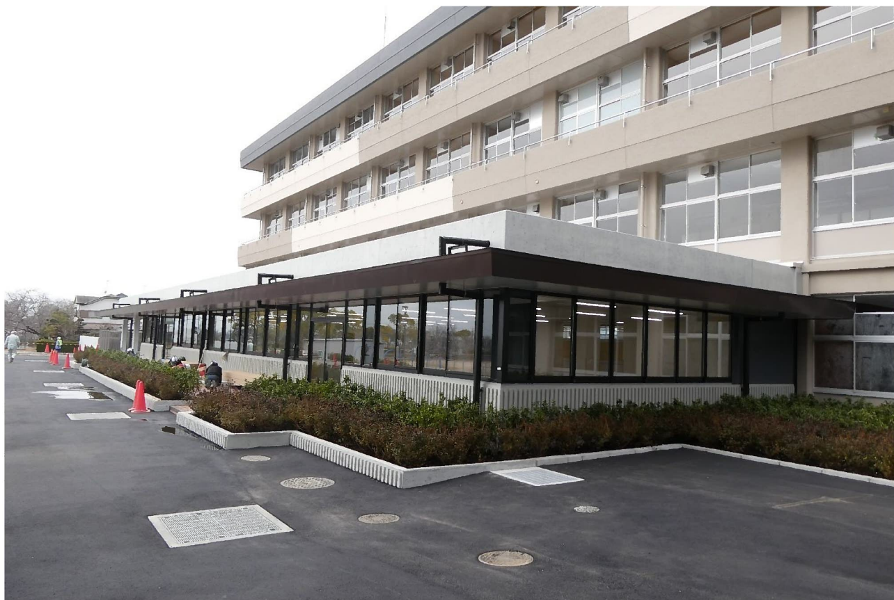
【完成】北校舎棟 職員室増築部分（令和7年1月27日撮影）
