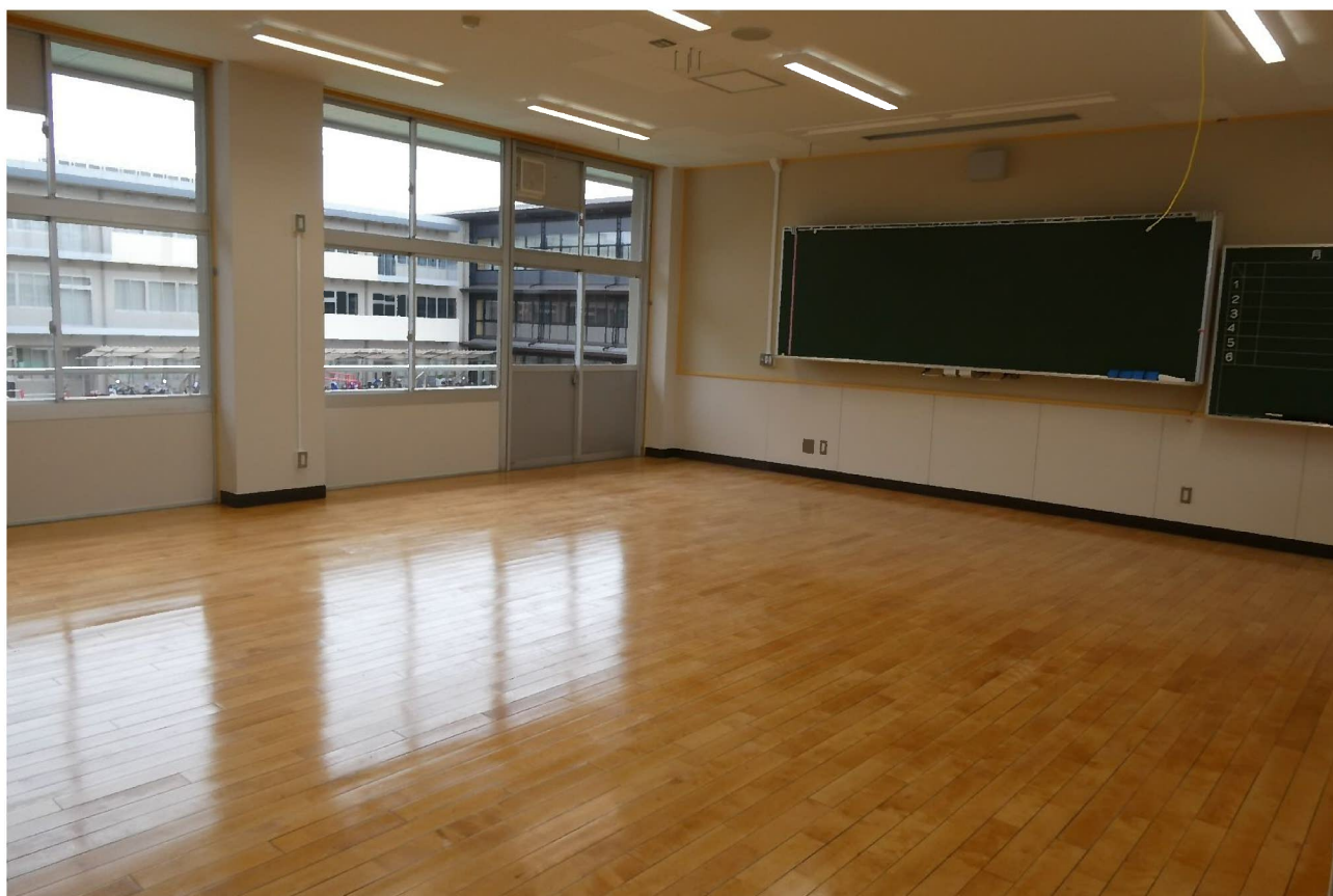
【完成】北校舎棟 教室（令和7年1月27日撮影）
