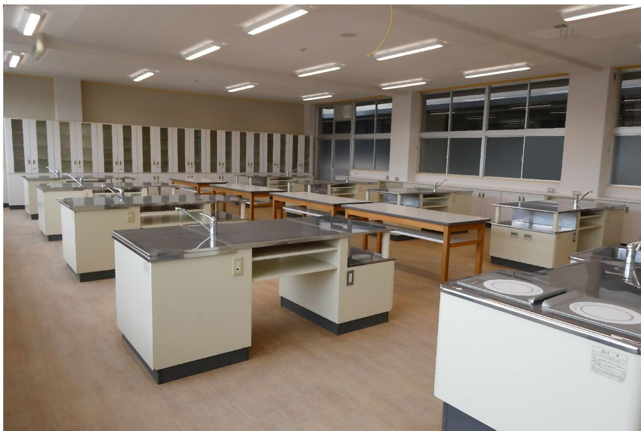
【完成】北校舎棟 調理室（令和7年1月27日撮影）
