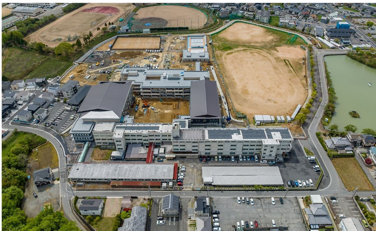
全景 北側上空から撮影（令和6年4月30日撮影）
