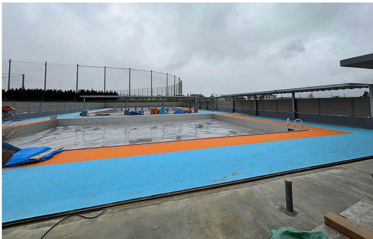
プール棟 小プール・大プール（令和6年4月23日撮影）
