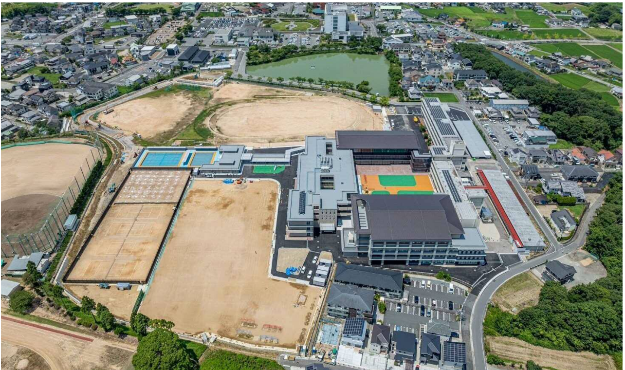
全景 東側上空から撮影（令和6年8月6日撮影）
