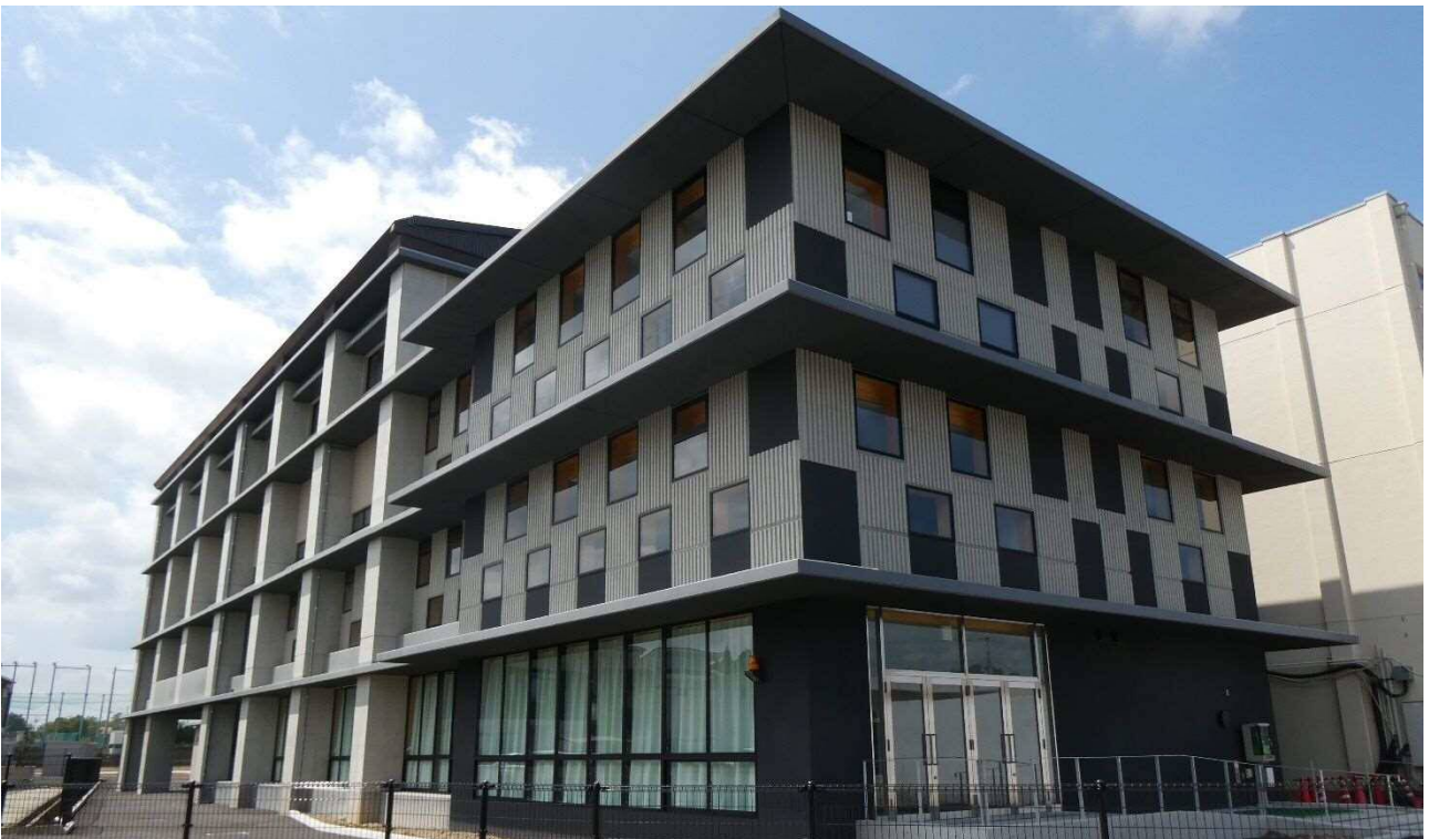
【完成】体育館棟（令和6年8月15日撮影）
