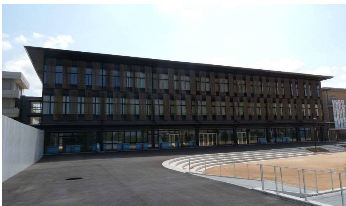
【完成】交流棟（令和6年8月15日撮影）
