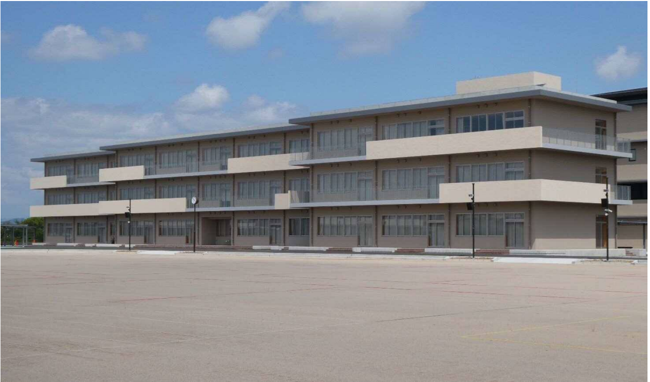
【完成】南校舎棟（増築校舎棟）（令和6年8月15日撮影）
