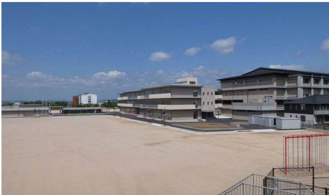
【完成】現場南東側からの工事状況（令和6年8月15日撮影）
