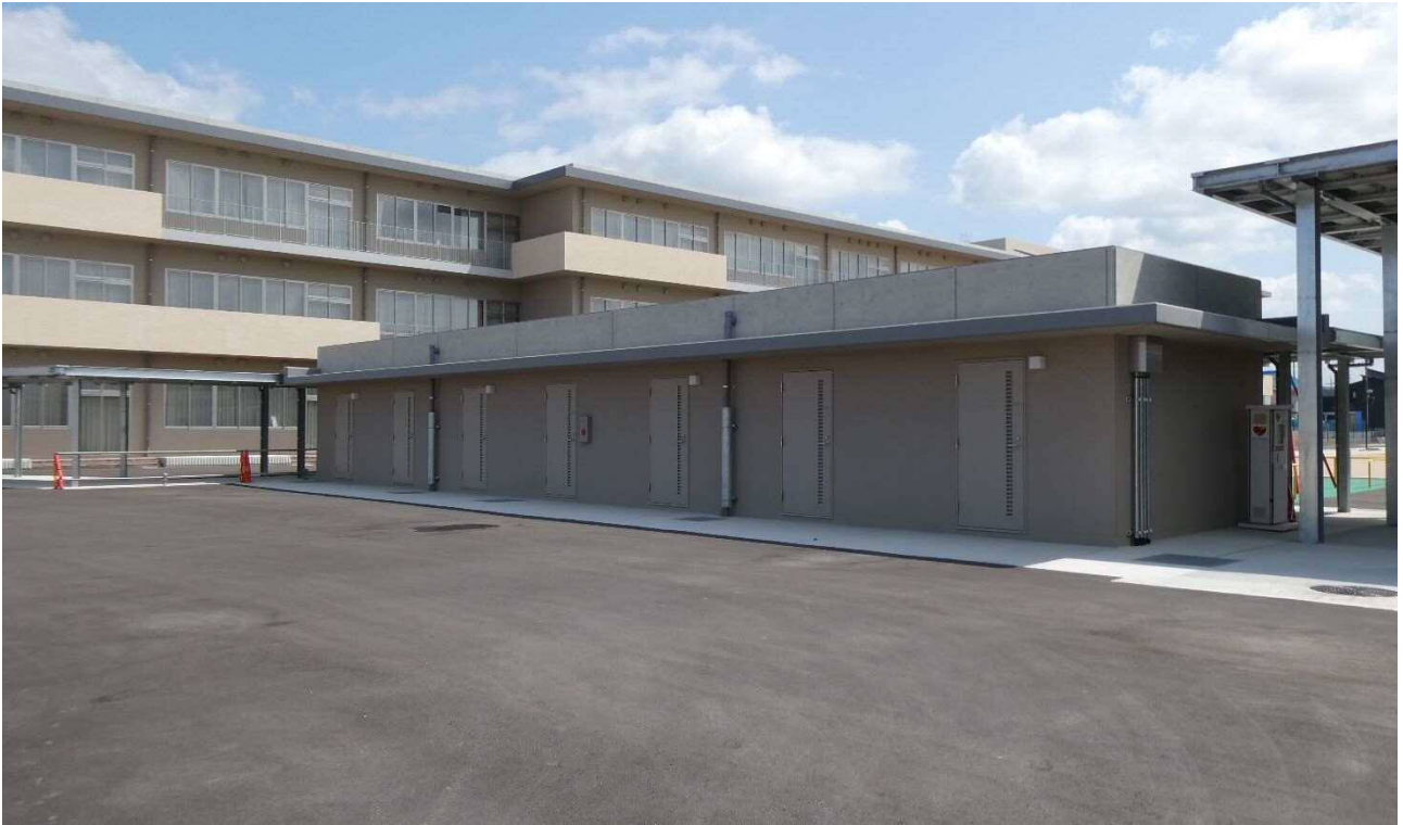
【完成】部室棟（令和6年8月15日撮影）
