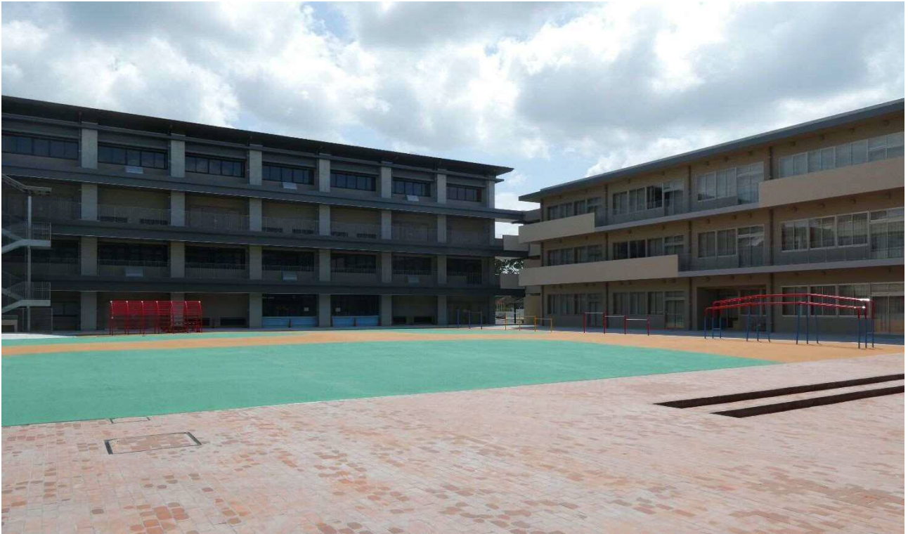
【完成】中庭（令和6年8月15日撮影）
