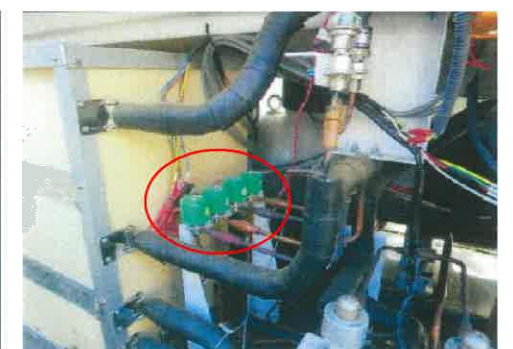
電磁弁交換 (電磁弁破損による冷却不足)
