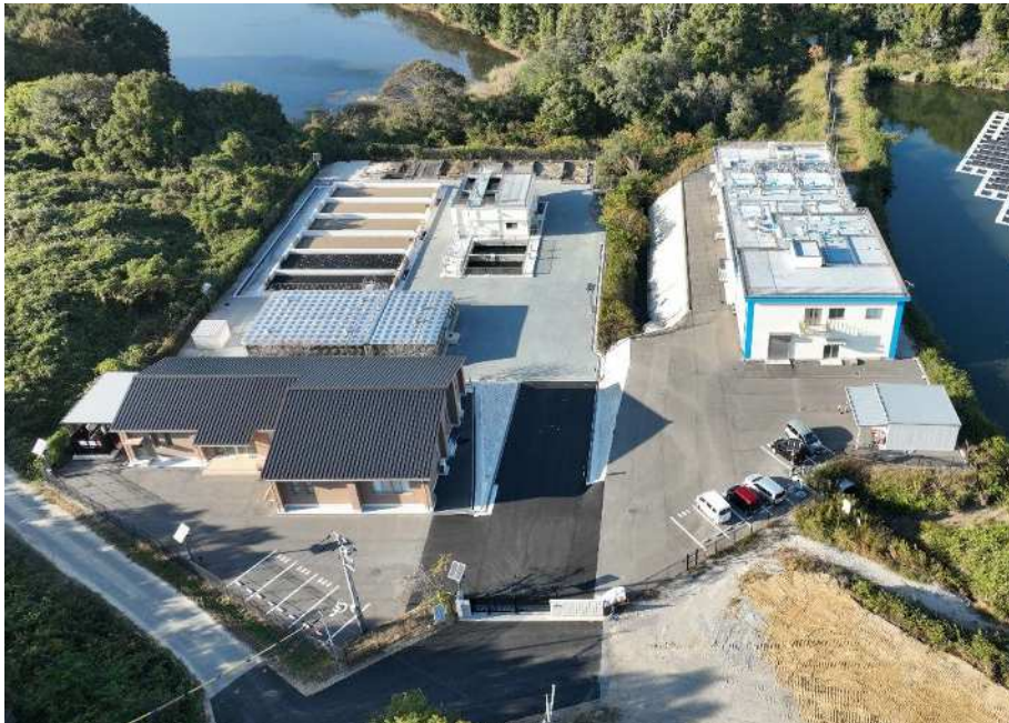
統合浄水場（広沢浄水場）完成写真
