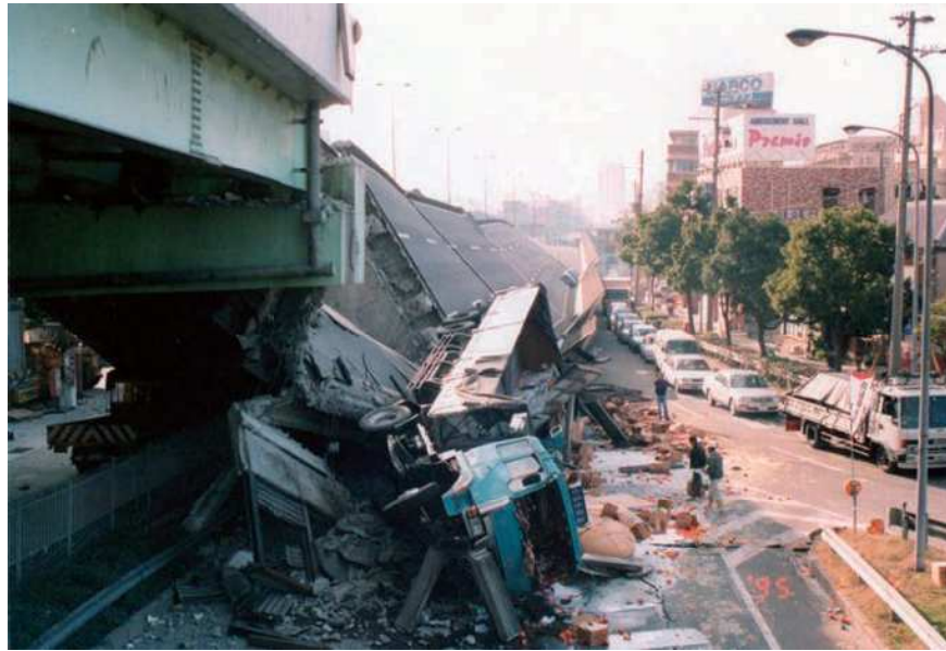
▲阪神淡路大震災(神戸市) 提供：神戸市
