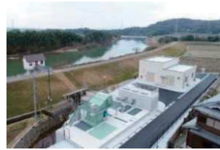
▲雨水ポンプ場(河高地区) 豪雨時の被害をへらすための排水施設です。停電しても使えるようになっています。
