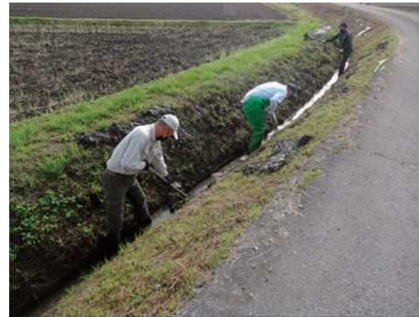
▲溝普請の様子(上田地区)
