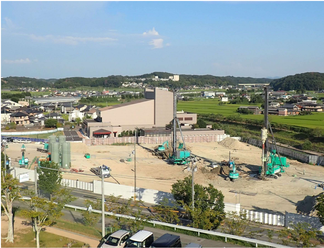
工事状況全景写真
