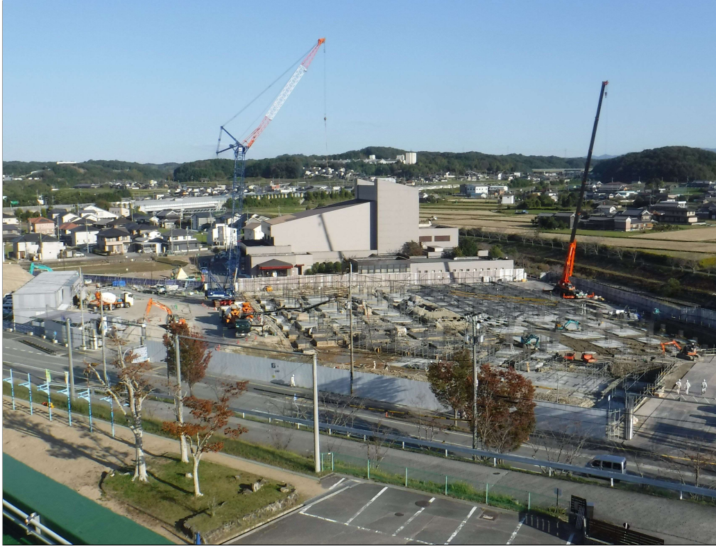
工事状況全景写真
