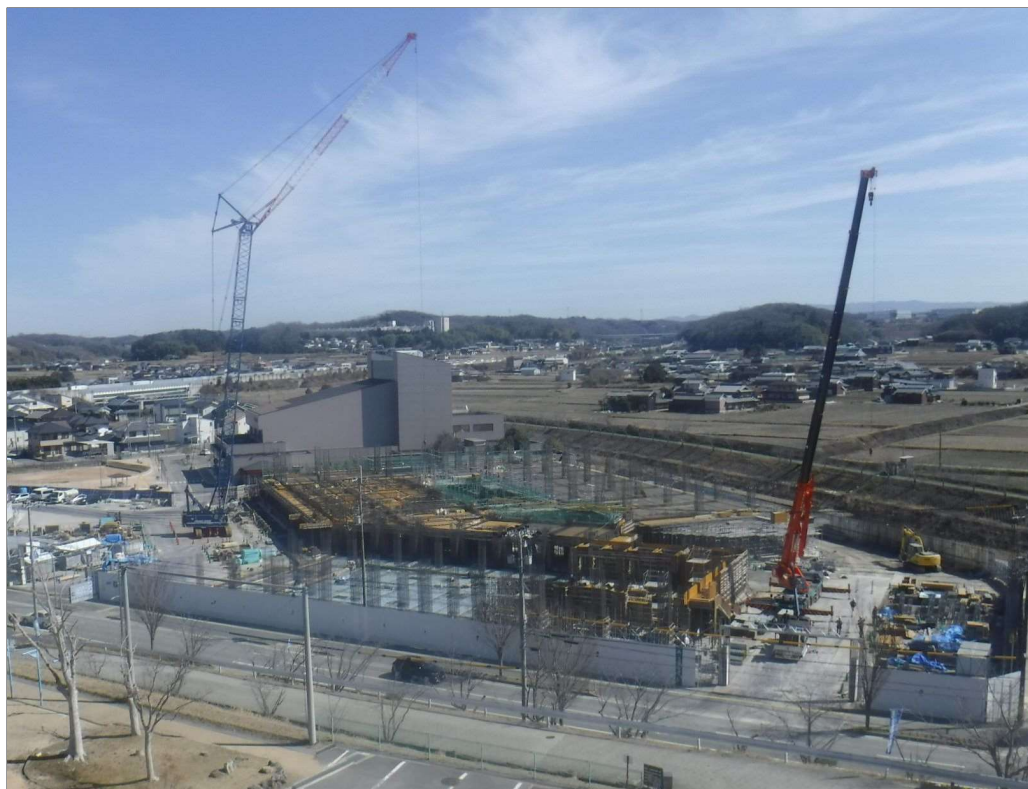
工事状況全景写真
