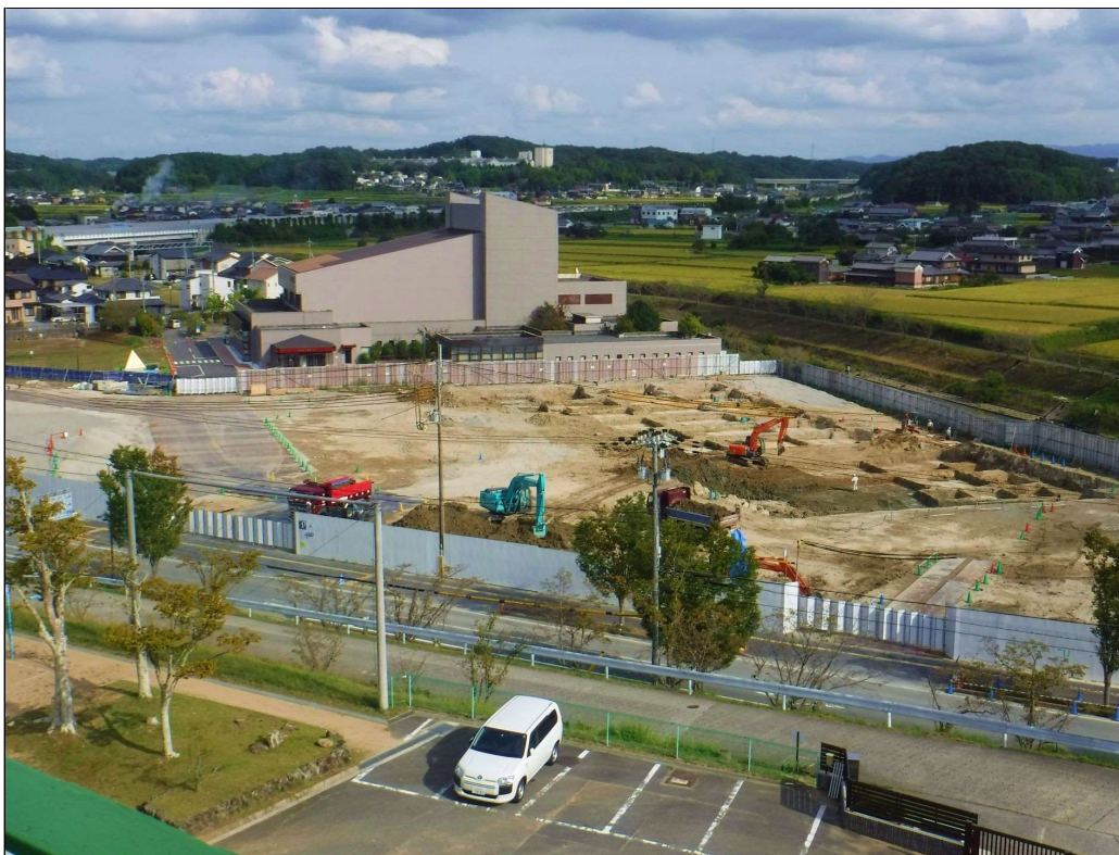
工事状況全景写真
