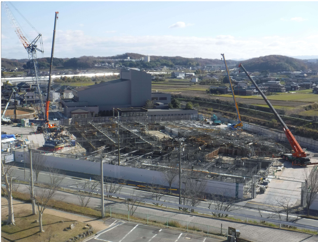
工事状況全景写真
