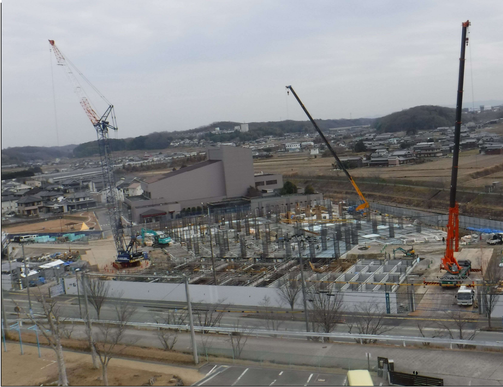
工事状況全景写真
