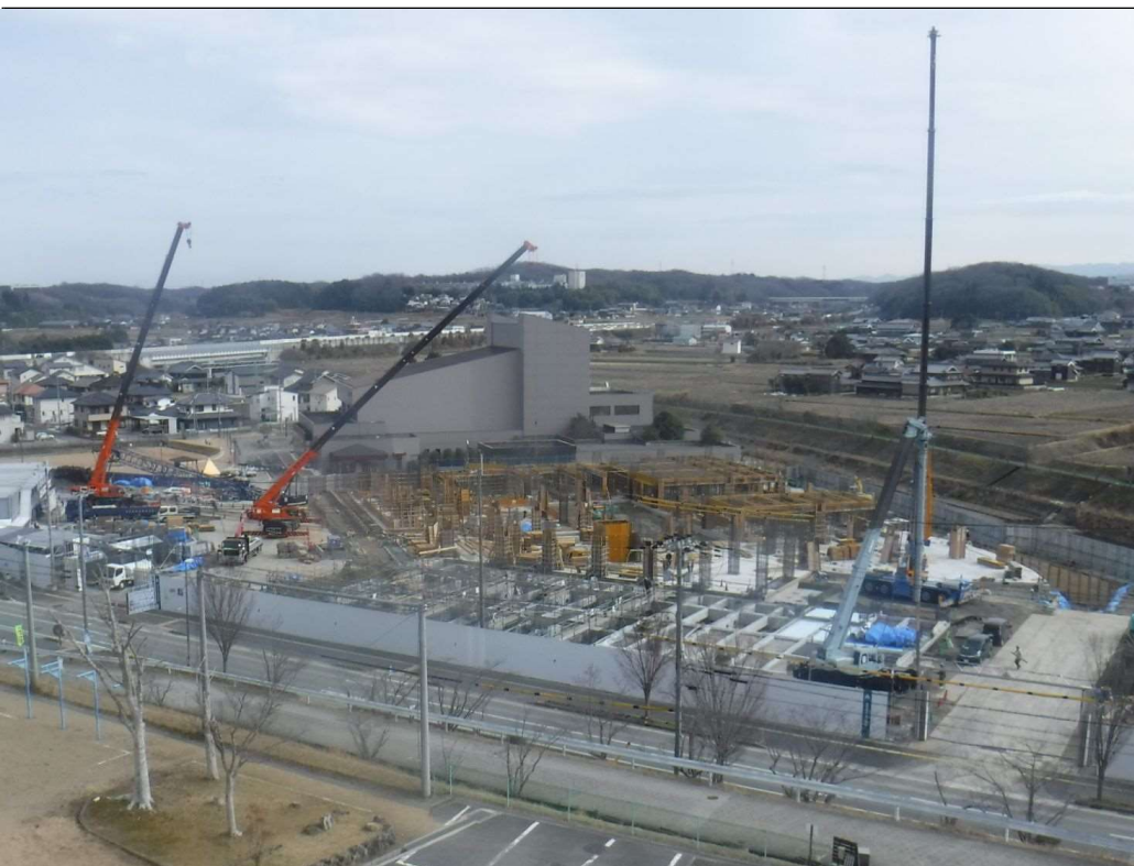
工事状況全景写真
