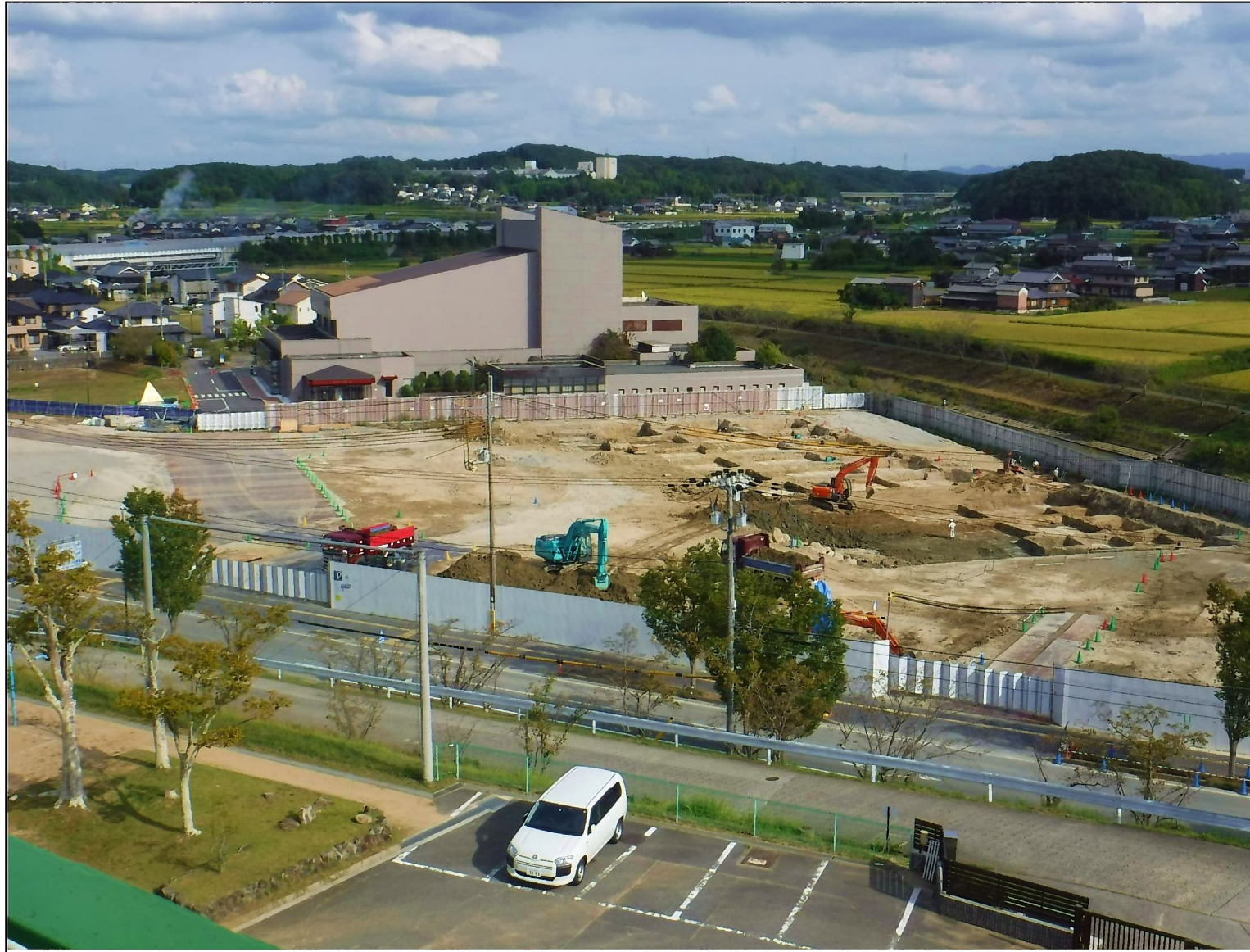
工事状況全景写真
