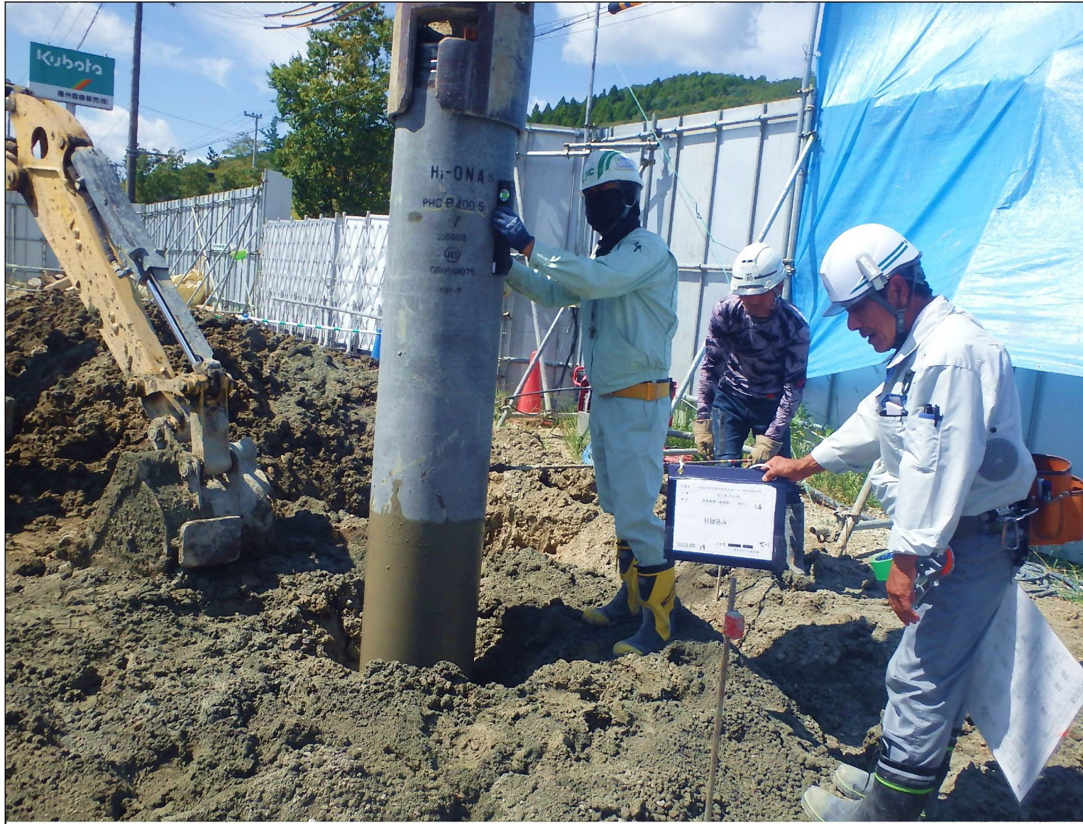
連絡橋(体育館側)杭施工状況写真
