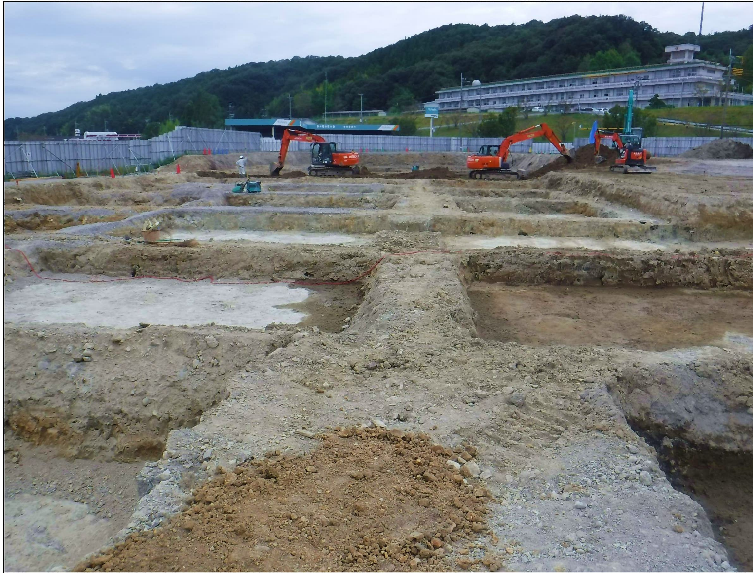
教室棟 掘削状況写真
