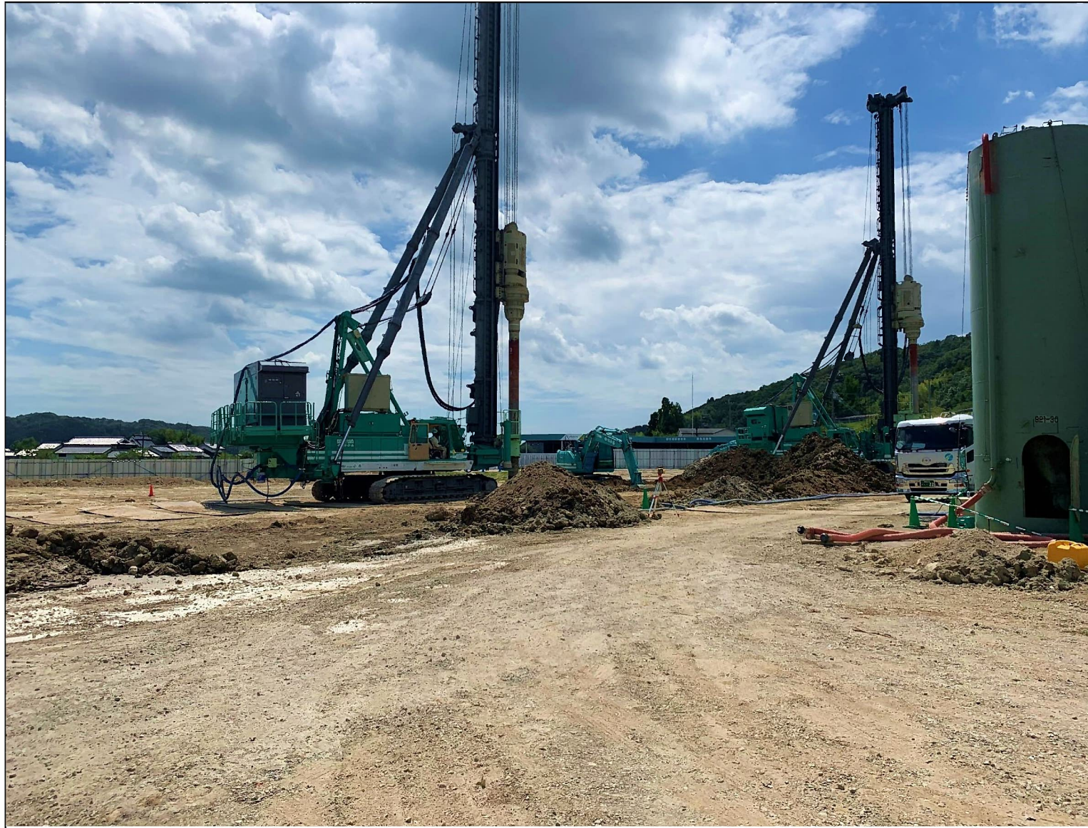
基礎下 柱状改良状況写真
