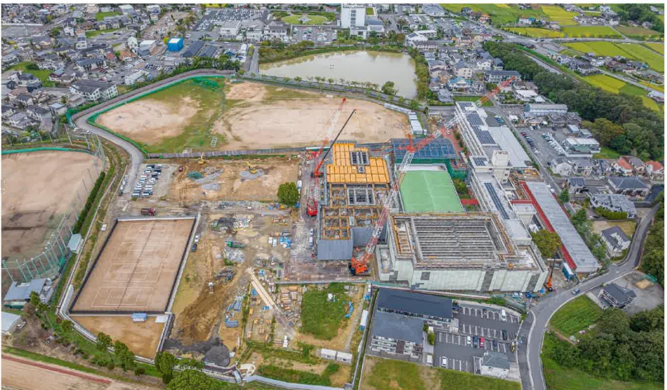
全景 東側上空から撮影（令和5年9月30日撮影）
