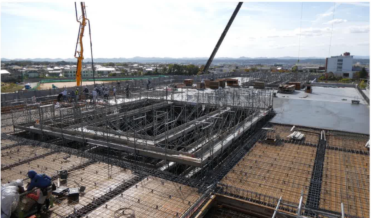
増築校舎棟 屋上階躯体工事状況 (令和5年10月13日撮影)
