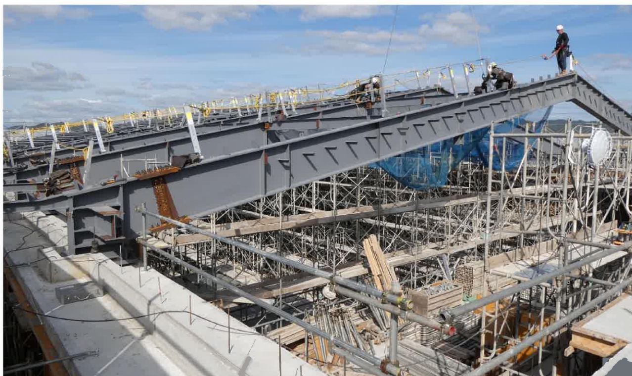
屋内運動場棟 屋根鉄骨建方状況（令和5年10月13日撮影）
