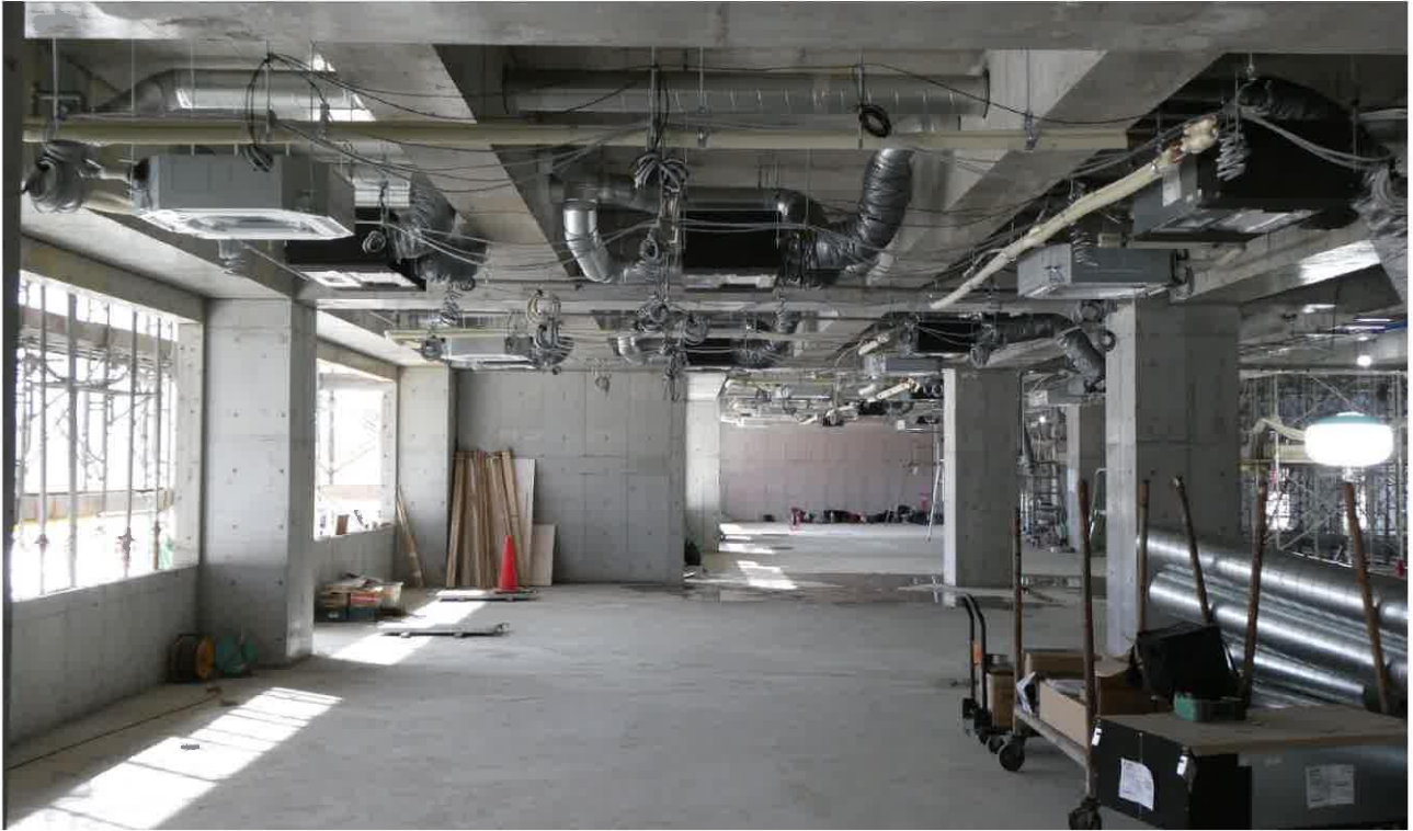
増築校舎棟 1階 内装工事状況 (令和5年10月13日撮影)
