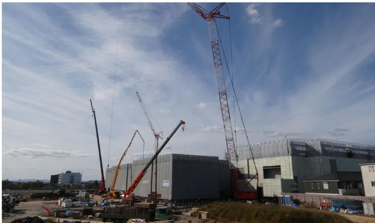
現場南東側からの工事状況（令和5年10月13日撮影）
