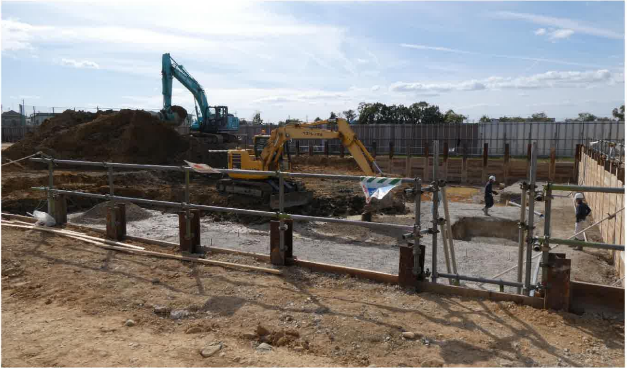
プール棟 掘削状況（令和5年10月13日撮影）
