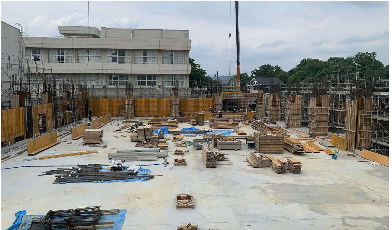
体育館棟 1階外壁及び柱 配筋、型枠建込状況（令和5年5月22日撮影）
