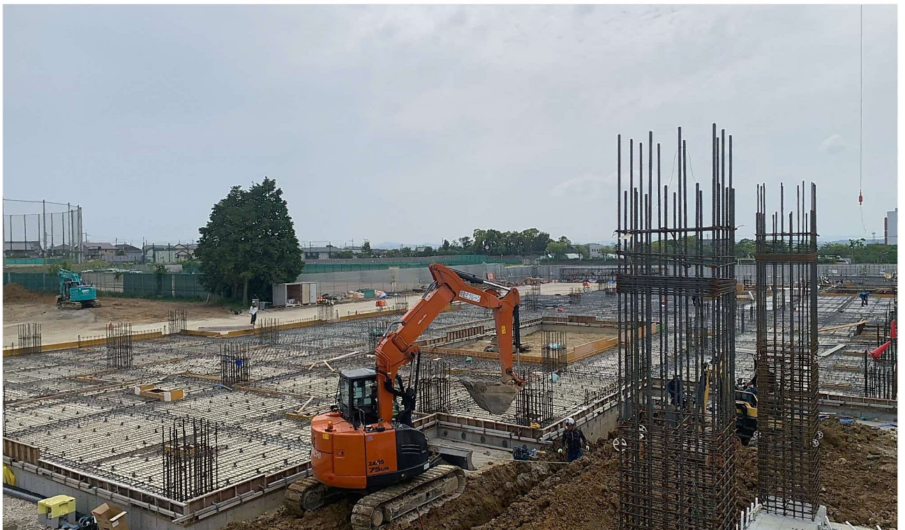
増築校舎棟 1階スラブ配筋状況（令和5年5月22日撮影）
