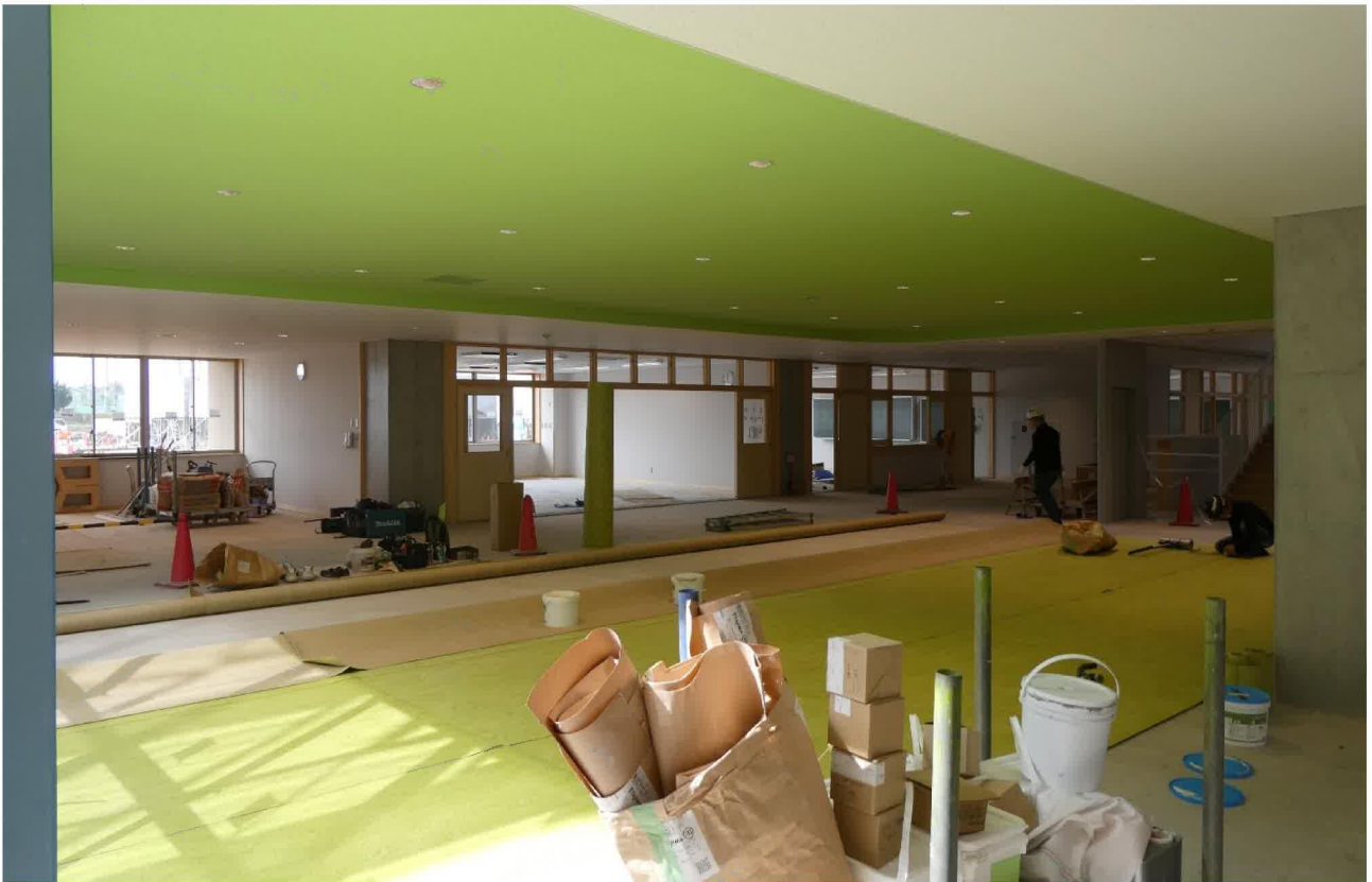
廊下・多目的スペース 内装工事状況（令和6年4月5日撮影）
