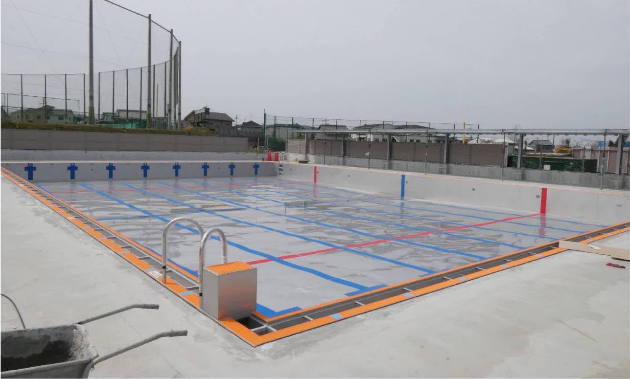
大プール施工状況 (令和6年4月5日撮影)
