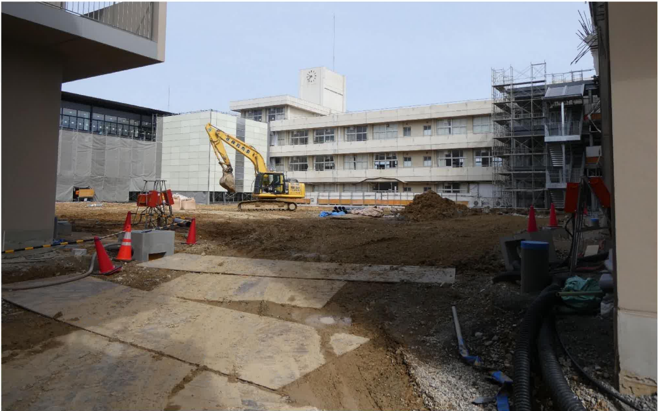
中庭 施工状況（令和6年4月5日撮影）
