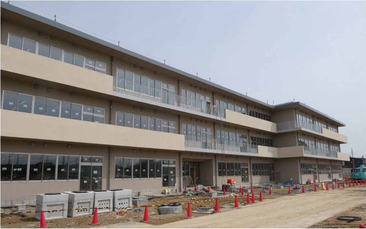
増築校舎棟 外観 (令和6年4月5日撮影)
