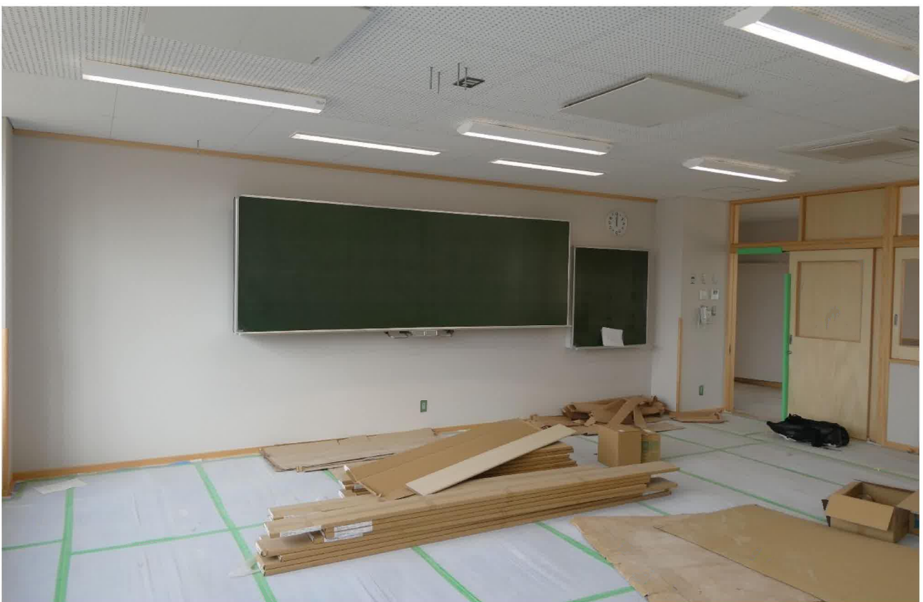
普通教室 内装工事状況（令和6年4月5日撮影）
