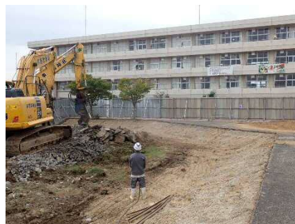
社中学校グラウンド階段解体状況 (R4.10.12時点)
