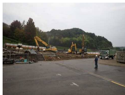
東条中学校校舎解体状況 (R4.10.12時点)
