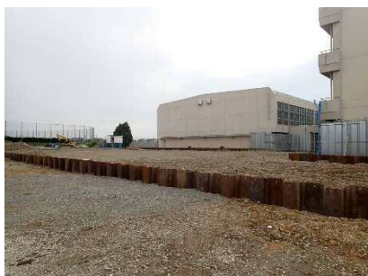
社中学校プール跡地の屋内運動場棟工事 (R4.10.12時点)
