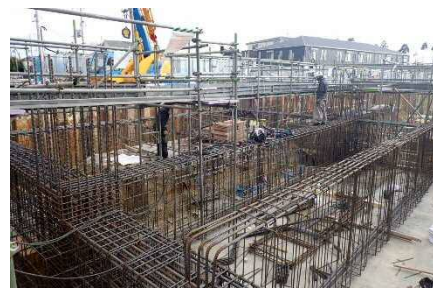
屋内運動場棟 配筋状況 (R5.1.31 時点)
