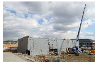
東条学園部室棟 建設状況 (R5.1.31 時点)
