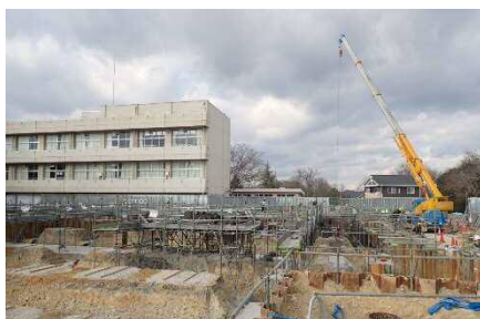
屋内運動場棟 工事状況 (R5.1.31 時点)
