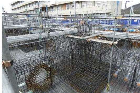
【特別教室棟(基礎配筋工事)】
