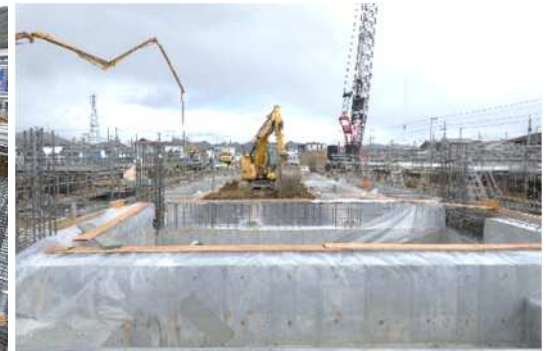
【屋内運動場棟(基礎コンクリート打設工事)】
