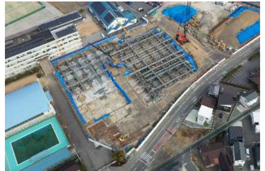
【南西から見た全体写真】
