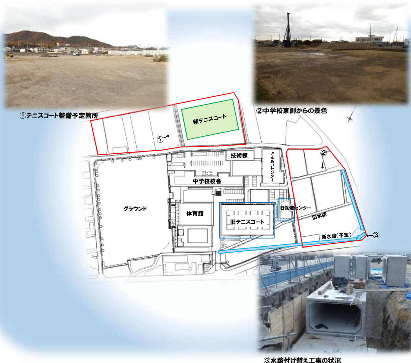
③水路付け替え工事の状況
