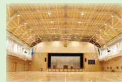
⑦大体育館：トラス構造で広々とした空間を実現しました。
