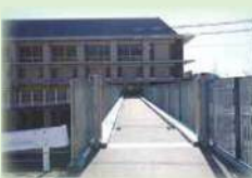
⑤学図橋：校舎棟と大グラウンドをつなぐ連絡橋です。
