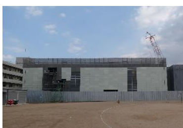
交流棟 工事状況
