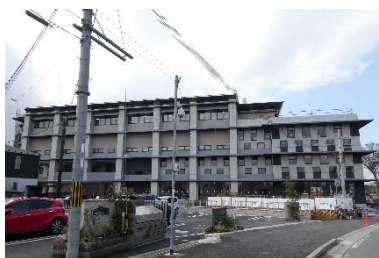
体育館棟 外装仕上げ状況
