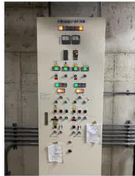
CP-3 水風呂ろ過制御盤 撤去更新
