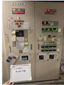
C-1 自動制御盤 撤去更新
