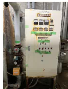
CP-4 ウタセろ過制御盤 撤去のみ
