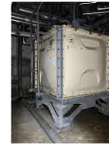
オーバータンク x2台 撤去のみ
