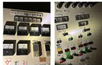
CP-5 ジャグジーろ過制御盤 撤去のみ
