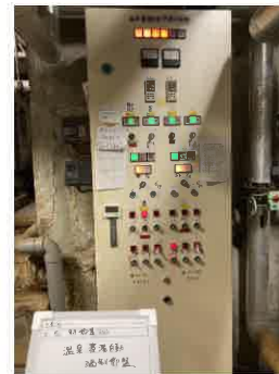
CP-1 温泉水循環ろ過制御盤 撤去更新
