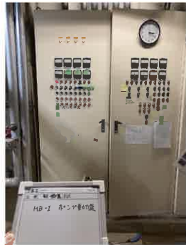
MB-1 動力線 撤去更新
